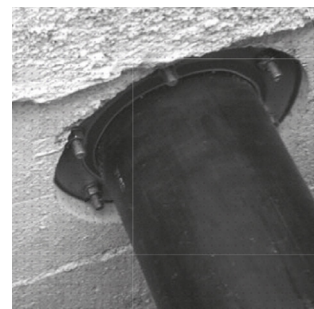
PS 2X40 : PRESSIO® STEEL REGULAR POUR TUBE PRÉ-ISOLÉ/ GAINÉ ANNELÉE (TUYAU TRÈS SOUPLE) DE LARGEUR 80 MM.
