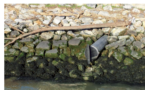
Vues du Tideflex® TF1 installé dans le Port de Montoir (44). Environnement difficile : marées, tempêtes, embacles.
