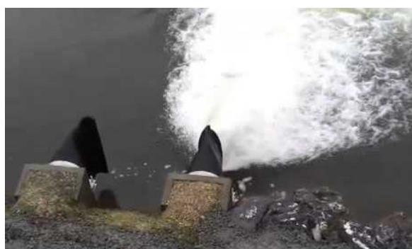
Vues des clapets Tideflex® TF2 installés sur la commune de Givet (08). Notez que l'absence de battant rend le dispositif incassable et capable de résister à de très fortes sollicitations hydrauliques ...
