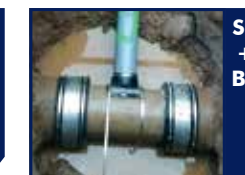
Réalisation d'un branchement.
